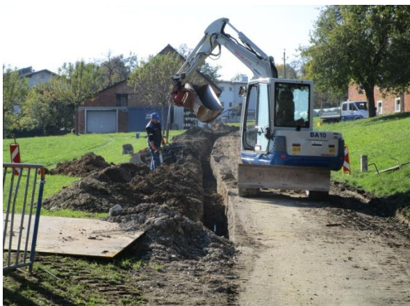
Leitungsbau in Kematen
